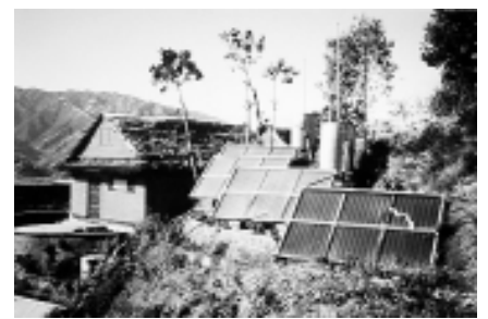
图 13b: 尼泊尔 Kathmandu 的太阳能热水器和室内采暖系统 照片由 Donald Aitken 博士拍摄
