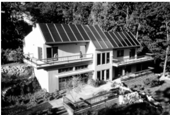
图 10a, b: 以各种形式输送太阳能。位于马萨诸塞州波士顿的房屋(太阳能设计协会设计),融合了能源效率设计、被动式太阳能空间采暖、白天照明、主动式太阳能室内采暖、太阳能热水以及太阳能发电,所有这一切构成了一座“零净能源”的房屋。但同样重要的是,太阳能的使用满足了发展中国家的基本需要,比如,淡水、照明和医药,右边图中示出了印度的光伏动力的淡水泵送过程。
