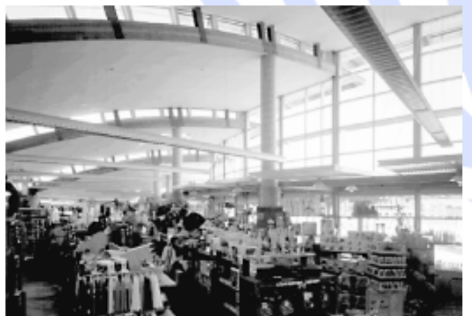
图 12a, b: Real Goods 太阳能生活中心，美国加利福尼亚 Hopland 的一家零售商店(由建筑师 Van der Ryn 设计)。完全的“生物气候”设计，建筑物融合了被动式太阳能加热、日光、自然通风和冷却、光伏发电和当地景观。相对于 Hopland 当地气候条件下的传统设计，节能约 90%。商店内的销售比预计的要高 50%，因为内部照明和舒适度非常好。
