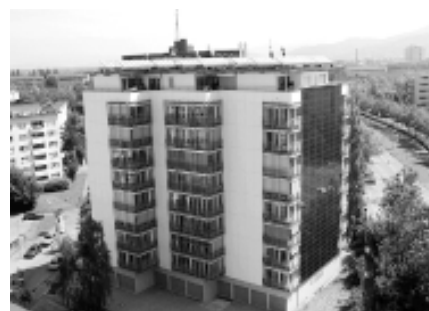
图 16b: 德国 Freiburg 的一座多户家庭建筑,该建筑利用屋顶进行太阳能加热水,而利用南墙进行太阳能电力生产。
