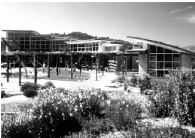
图 12a, b: Real Goods 太阳能生活中心，美国加利福尼亚 Hopland 的一家零售商店(由建筑师 Van der Ryn 设计)。完全的“生物气候”设计，建筑物融合了被动式太阳能加热、日光、自然通风和冷却、光伏发电和当地景观。相对于 Hopland 当地气候条件下的传统设计，节能约 90%。商店内的销售比预计的要高 50%，因为内部照明和舒适度非常好。
