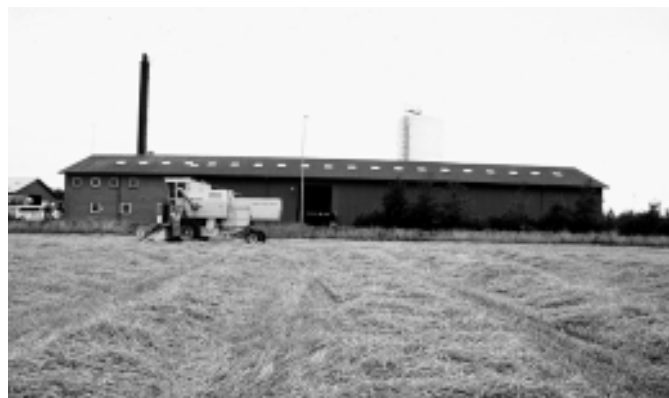
图 6b：社区热电联产(CHP)发电厂，以附近生长的废秸秆作燃料，供应丹麦300户家庭 照片由 Donald Aitken 博士提供
