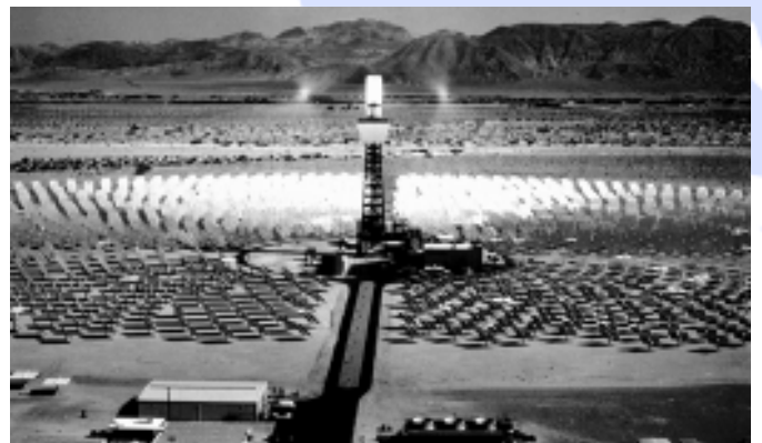
图 14b：太阳能 1 号，加州南部的 10 MW “电力塔”。
