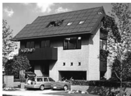
图 16a: 日本的一座户用太阳能屋顶应用。 来源: 日本光伏协会照片
