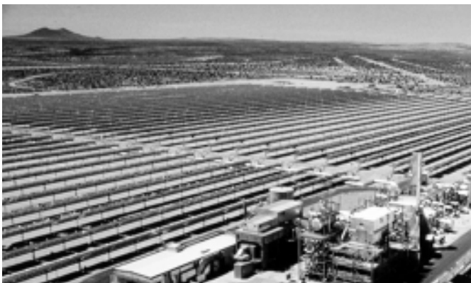
图 14a：世界上最大的太阳能热电发电机(左图)，加州 354 MW 系统的一部分。图中还示出了嵌入的燃气发电机，在“混合”运行中占 25%，以平衡太阳能系统的输出，从而形成可再生能源和传统能源生产间的有效协同。
